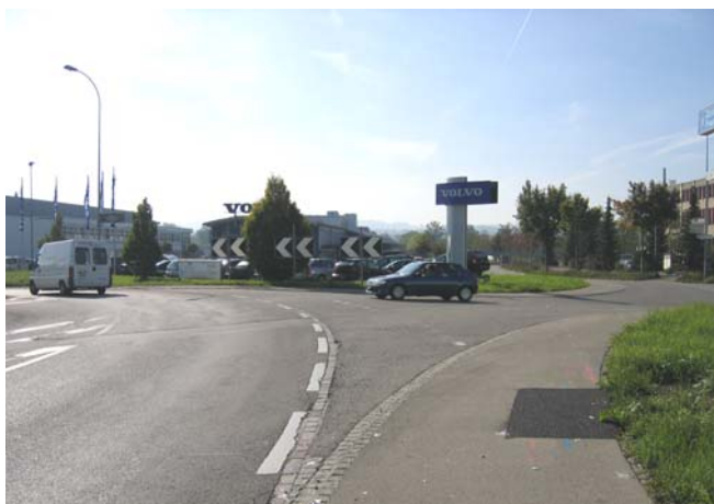
Dunant-/Dufourstrasse: Vor dem Bau des Kreisels
