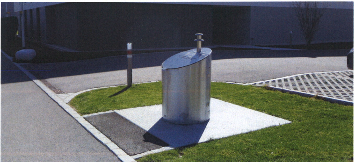
realisierter Unterflurcontainer an der Leuestrasse
