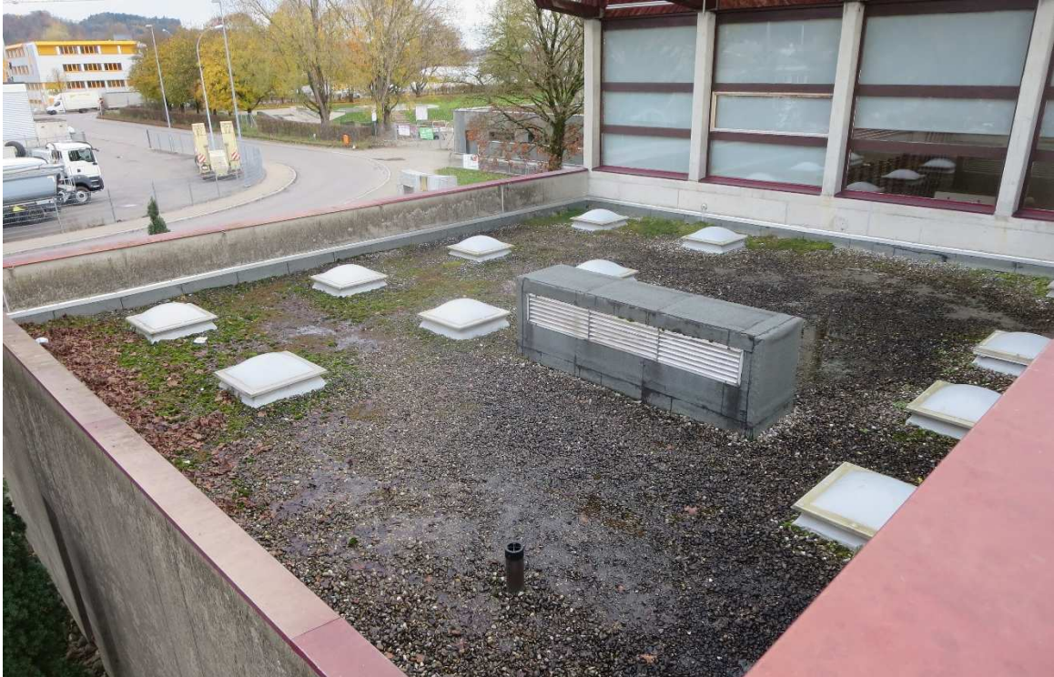
Flachdach Vorbau West, Bereich Nord, mit Oblichtern: teilw. Schliessung Oblichter, zusätzliche Dämmung
