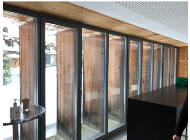
Sprossenfenster OG Debrunnerhaus
