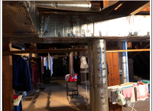
Dämmung oberste Geschossdecke teilweise nicht existent.
